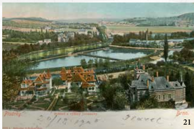
Usazovací bazény brněnské vodárny pod osadou Kamenný Mlýn na pohlednici odeslané v roce 1905.
