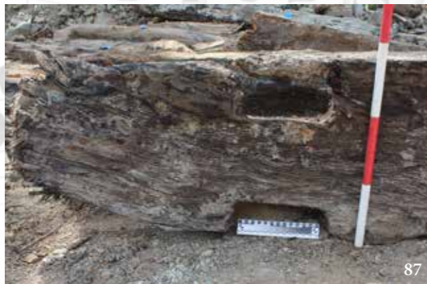
Detail tesařských spojů – zádlabů na dřevěném trámu získaném z prostoru mlýnského náhonu
