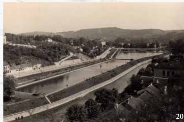
Pohled na silnici od Kamenného Mlýna do Pisárek, která vedla kolem dnes již zasypaných usazovacích nádrží brněnské vodárny (30. léta 20. století).
