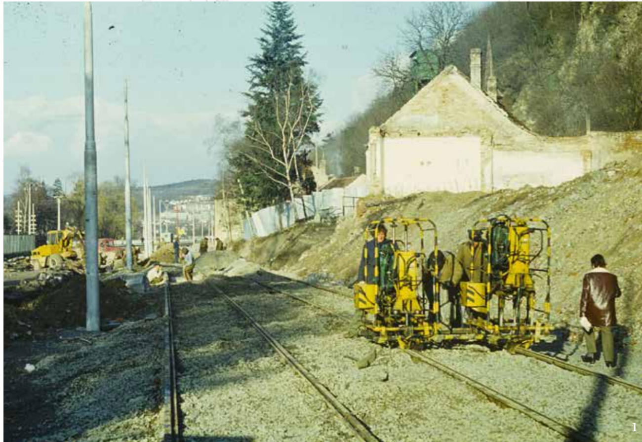
Budování tramvajové trati Kamenomlýnskou ulicí v roce 1975
