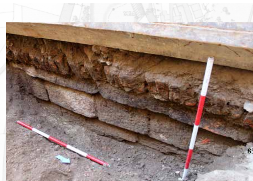
Kamenné zdivo stěny náhonu z 19. století s úpravou jeho koruny pomocí cihel kladených na kant
