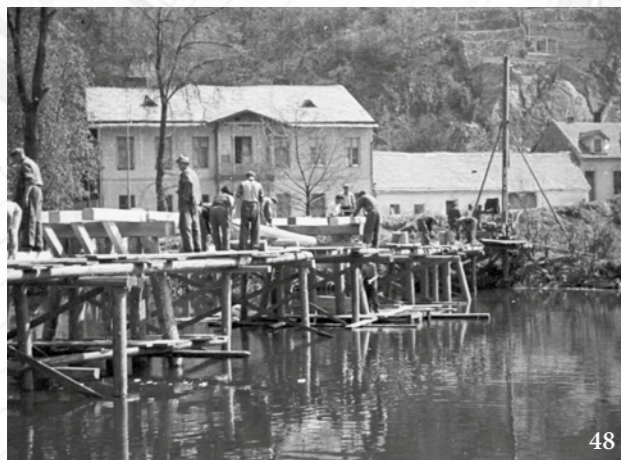
Stavba provizorní dřevěné lávky pro pěší v Kamenném Mlýně, která nahradila válkou zničený moderní most.
